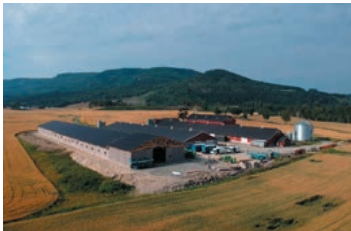
Kalkonstallet i Kongsberg är det andra bygget som MG-Bbygg utför där.
